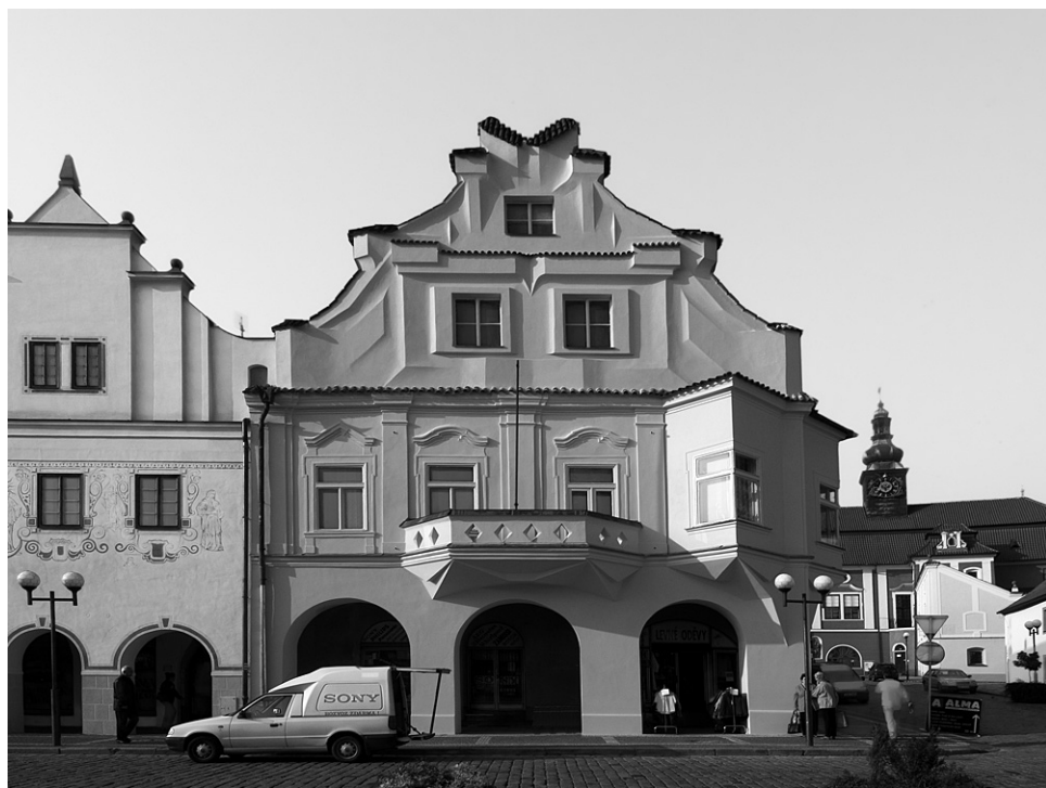
Obr. 3. Fárův dům (přestavba Pavel Janák, Masarykovo náměstí 13, Pelhřimov, 1913). Zdroj: Ester HAVLOVÁ, Fárův dům 1, Archiweb, Stavby: Fárův dům. Dostupné z: https://www.archiweb.cz/b/faruv-dum--1 [náhled 20-11-2025].
